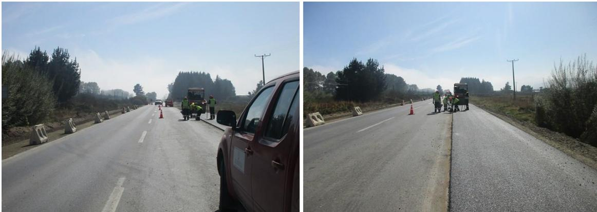
**Colocación de Base Granular y Compactación de Sello de Fundación de Contrafosos en Corte, Sector Chivilingo Tramo A Sector II Lado Izquierdo en km: 40,000 – 40,400.**
