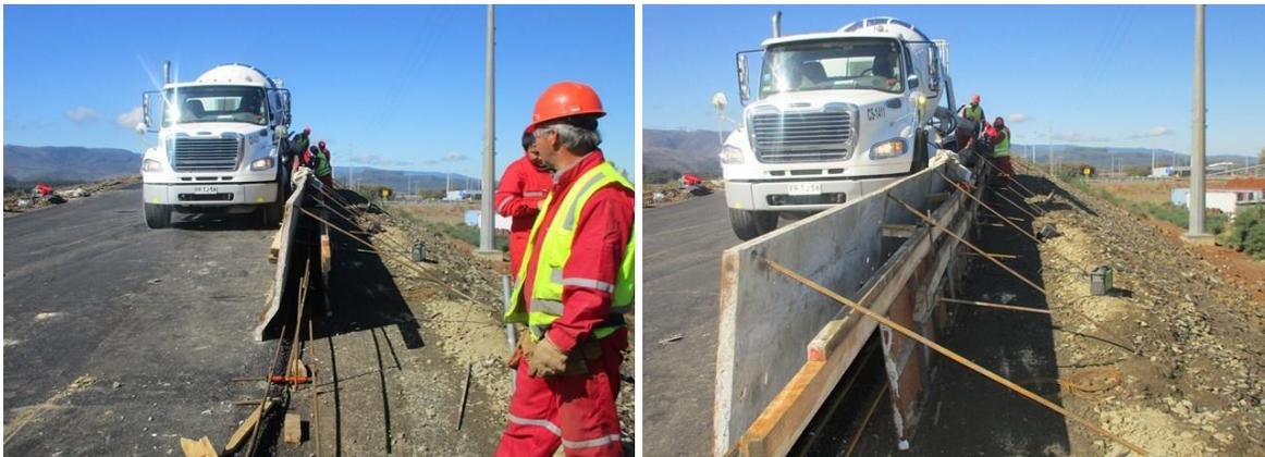
**Instalación de Moldajes y Enfierraduras para la Construcción de Barreras Hormigón Tipo F, Eje N° 10 Laraquete Sur
